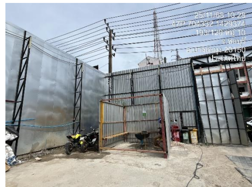
ภาพที่ 2 ประตูทางเข้า-ออก และรั้ว Metal Sheet ความสูง 6 เมตร
