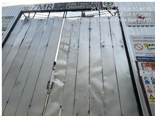
ภาพที่ 2 ประตูทางเข้า-ออก และรั้ว Metal Sheet ความสูง 6 เมตร
